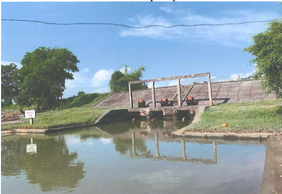
Cống Tứ Thôn Cùm Bắc Hưng Long
