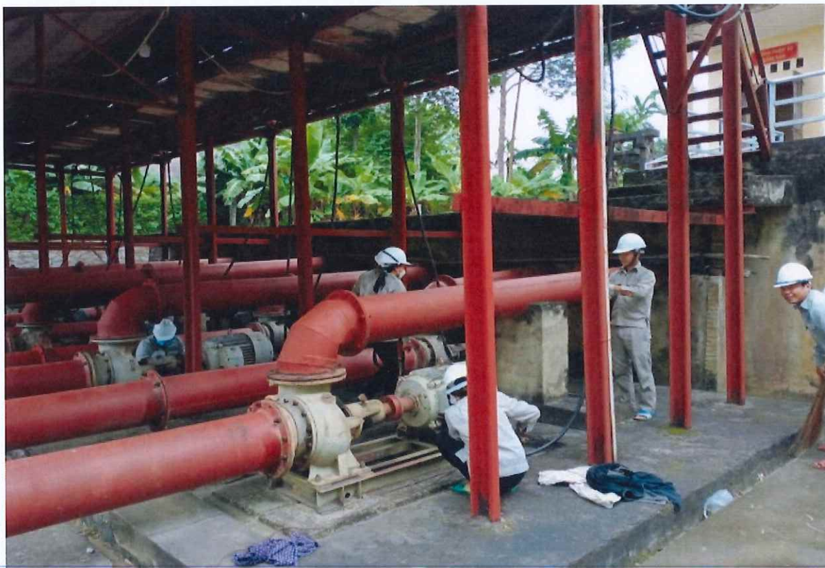
Công nhân vận hành cụm tổ trạm bơm Châu Lộc bảo dưỡng máy móc thiết bị
