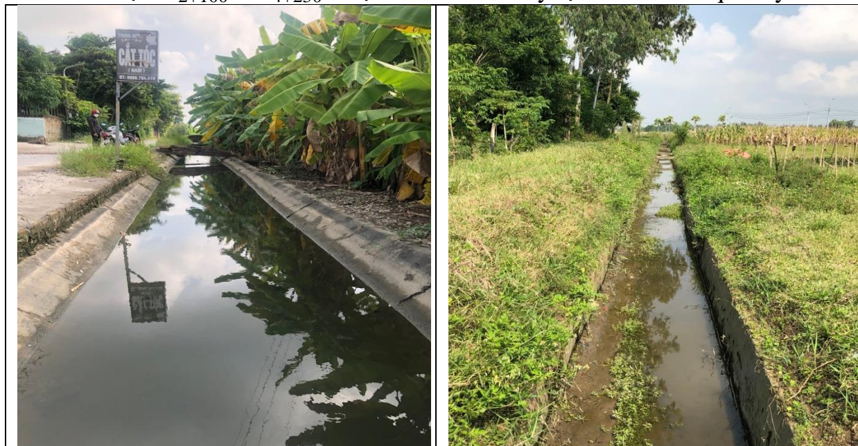
Đoạn đầu kênh lát
