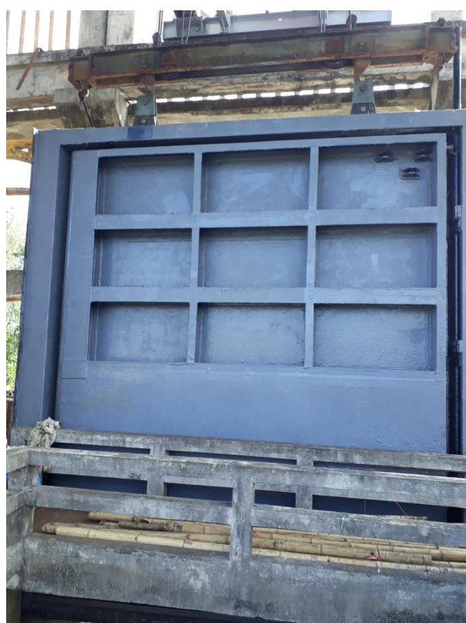
Thi công bọc composit cánh van
