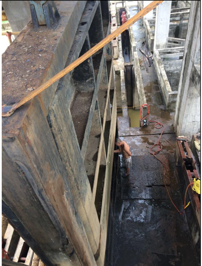
Thi công sửa chữa cánh van
