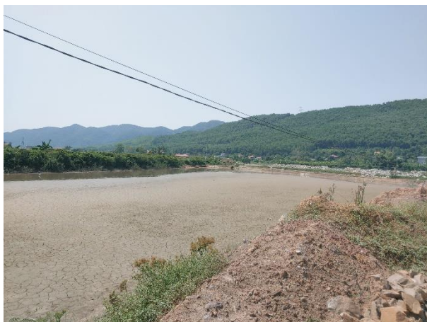
(Đầu tuyến kênh - Phễu, xã Hà Tiến)
