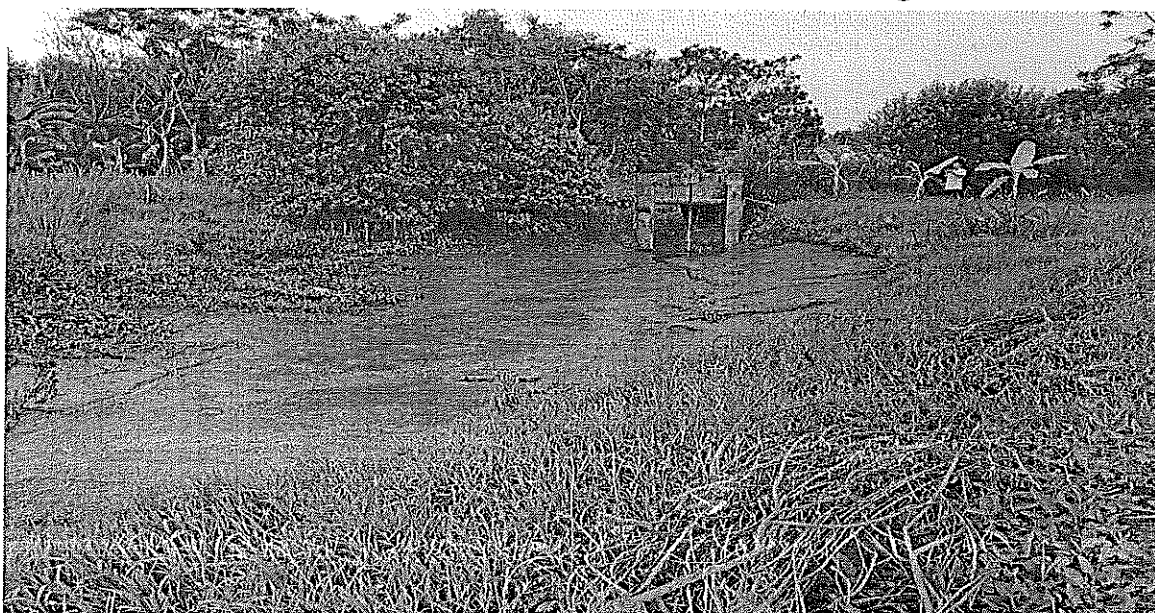
Ảnh hiện trạng kênh dẫn bể hút TB Phong Lộc bị bồi lắng.
